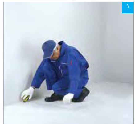
۱ مشخص کردن محل نصب رانر کف با ریسمان رنگی
