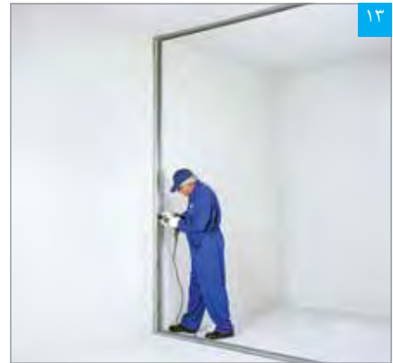
نصب استادا بر روی ساختار جانبی (سوراخ کردن استادا و دیوار)
