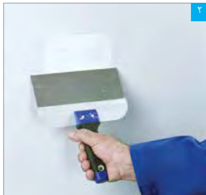
۲ اجرای بتونه بر روی وصله ترمیمی
