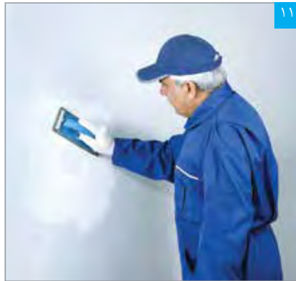
۱۱ پرداخت سطح بتونه کاری شده و آماده سازی جهت پذیرش پوشش نهایی
