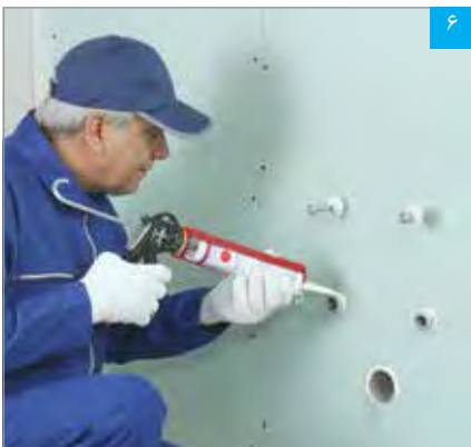
اجرای خمیر درزبند در اطراف خروجی‌های تاسیساتی
