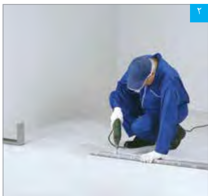
نصب رانر کف
