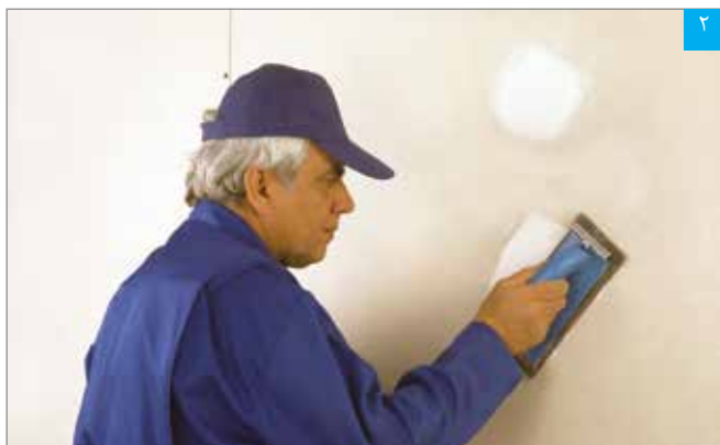
پرداخت سطح بتونه خشک
