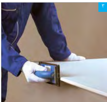
پرداخت وجه عمودی لبه پخ خورده با ساب مال‌های
