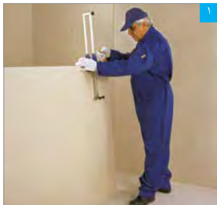
برش پنل با دستگاه برش طولی
