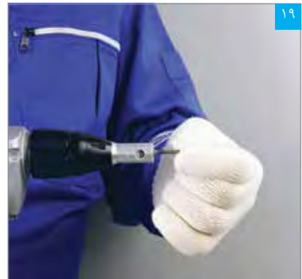
برای نصب پنل‌ها از پیچ مخصوص و دستگاه پیچ زن استفاده می‌شود
