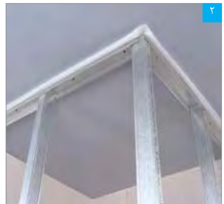
شکستن نوار چسب جداکننده پس از نصب سازه‌ها
