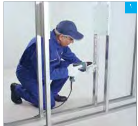
اتصال قطعات نبشی L25 به استادهای مجاور
