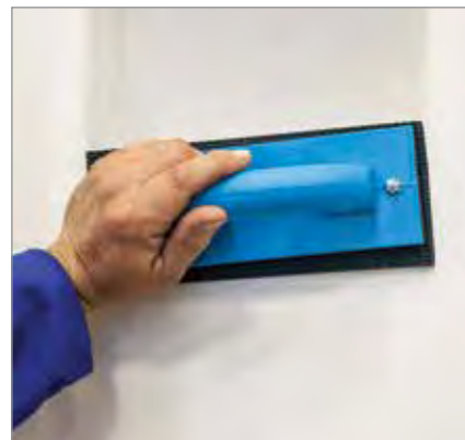
مرطوب کردن سطح دیوار با اسفنج نمدار
