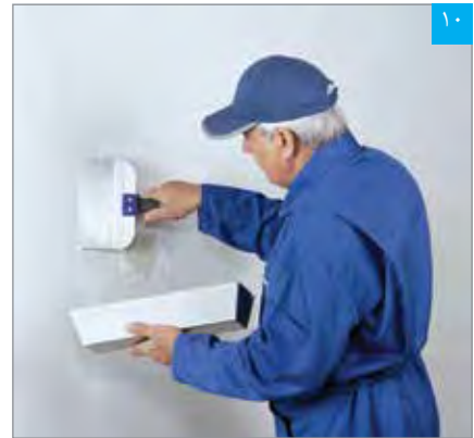
۱۰ بتونه کاری درزها در محل ترمیم (با استفاده از نوار و بتونه درزگیر)
