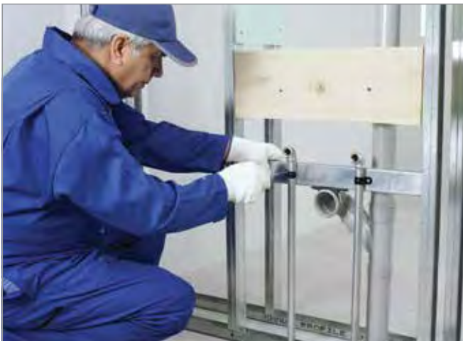
اتصال لوله‌های تاسیساتی به سازه پشتیبان SP60
