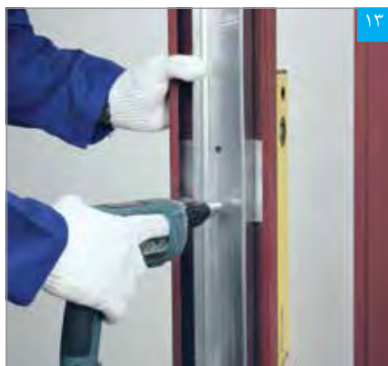
چهارچوب توسط پیچ LB در محل صفحات نصب به استاداها متصل می شود
