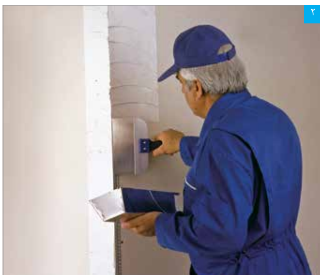
اجرای بتونه روی سازه محافظ گوشه
