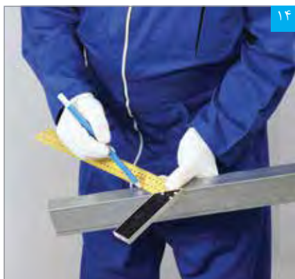
علامت گذاری انتهای رانر نعل درگاه به صورت فارسی بر (به اندازه ۲۰ سانتی متر)
