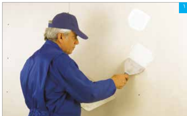
اجرای بتونه در محل پیچ‌ها
