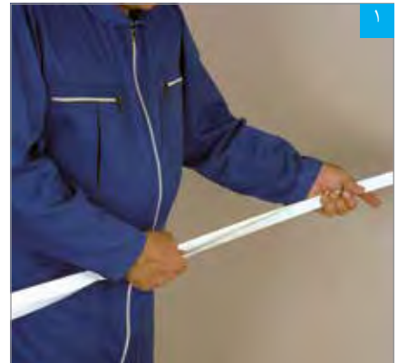
خم کردن نوار درزگیر با دست
