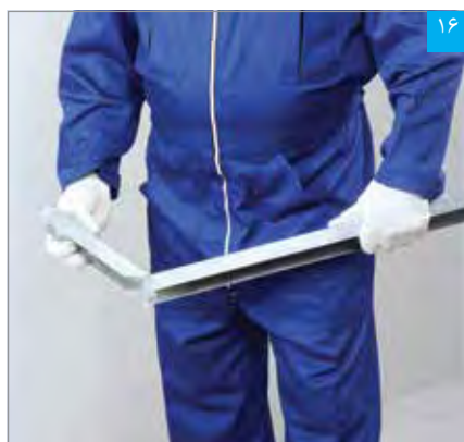
خم کردن انتهای رانر نعل درگاه
