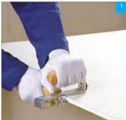
برش پنل با دستگاه برش قرقره‌ای
