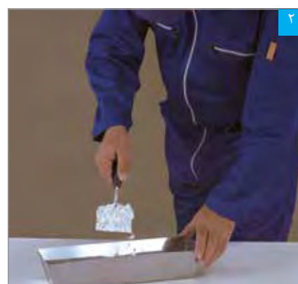
ریختن پودر بتونه در آب
