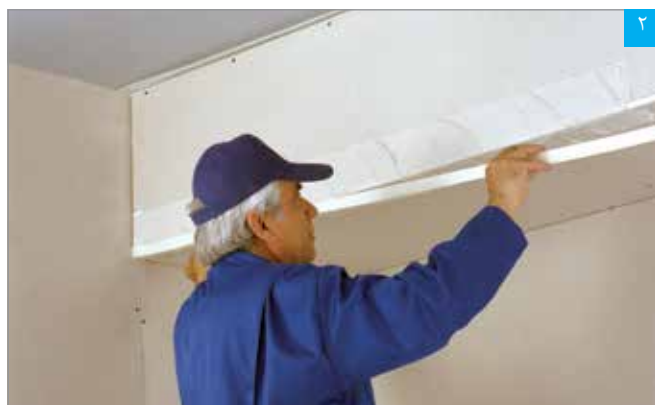
قرار دادن نوار درزگیر بر روی بتونه
