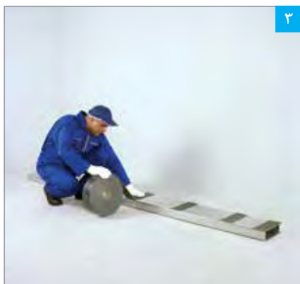
اجرای نوار عایق بر روی استاداها
