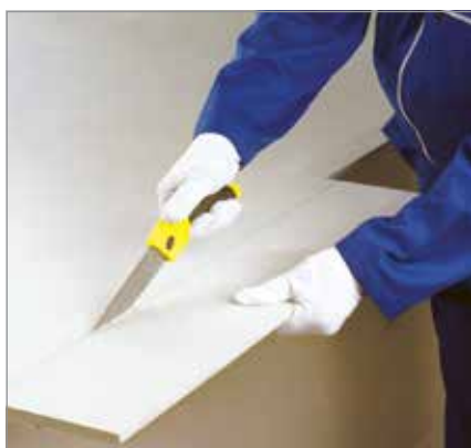
برش پنل با اره دستی
