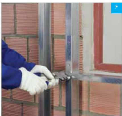
اتصال رانر قاب‌بندی تحتانی به استاد به وسیله پانچ، پرج با پیچ (به جهت برش ۴۵ درجه توجه شود)
