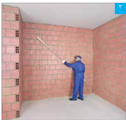
شمشه‌گذاری به صورت مایل بر روی دیوار زمینه، جهت تعیین ناترازی آن و علامت‌گذاری روی سقف
