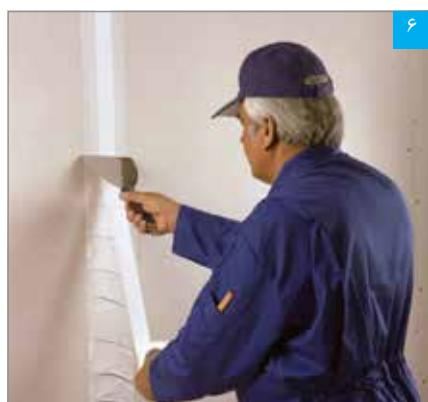
قرار دادن نوار درزگیر بر روی بتنه
