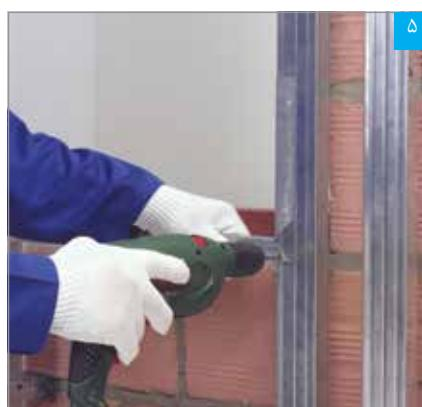
اتصال سازه قاب‌بندی به سازه قائم به وسیله پرج یا پیچ (به جهت برش ۴۵ درجه توجه شود)
