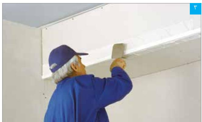
تشییت و شکل دهی نوار درزگیر با کاردک زاویه خارجی
