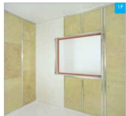
در محل بازشوی پنجره، برش پنل به صورت «C» شکل
