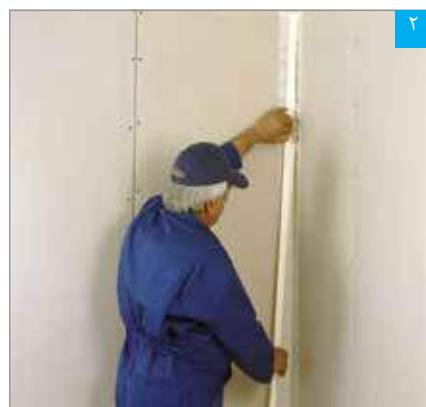
قرار دادن نوار درزگیر بر روی بتنونه
