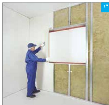
برش پنل با استفاده از تیغ برش
