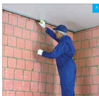
مشخص کردن محل نصب برآکت ها بر روی دیوار زمینه
