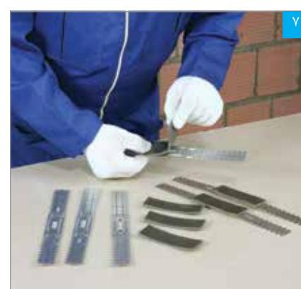
نصب قطعات فوم (عایق) بر پشت برآکت ها
