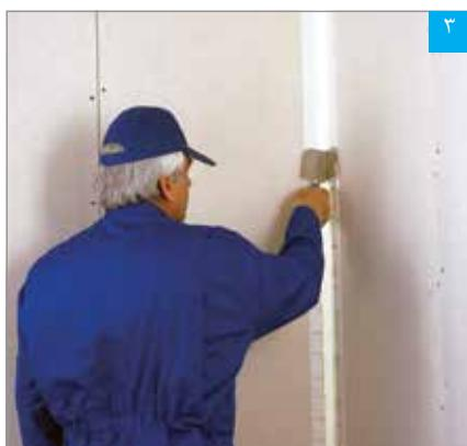
تشییت و شکل دهن نوار درزگیر با کاردک زاویه خارجی
