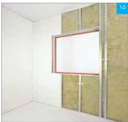
در محل بازشوی پنجره، پنل به صورت «C» شکل می‌گیرد
