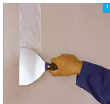
مرحله اول درزگیری: اجرای لایه بتنه در محل درز (کاردک درجهت عمود بر درز کشیده می‌شود تا بتنه کاملاً در درز نفوذ کند)
