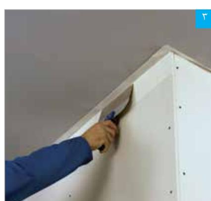
بتنونه کاری در فصل مشترک دیوار خشک و سقف بنایی
