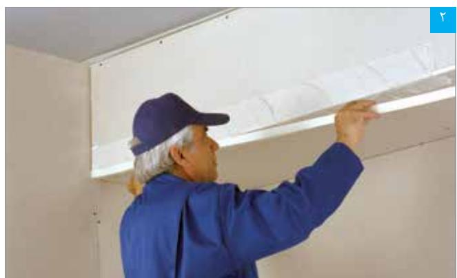
قرار دادن نوار درزگیر بر روی بتونه
