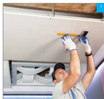
۱ تعیین محل نصب دریچه و ترسیم ابعاد بر روی پنل
