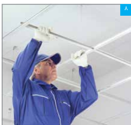
اجرای سازه‌های فرعی T600
