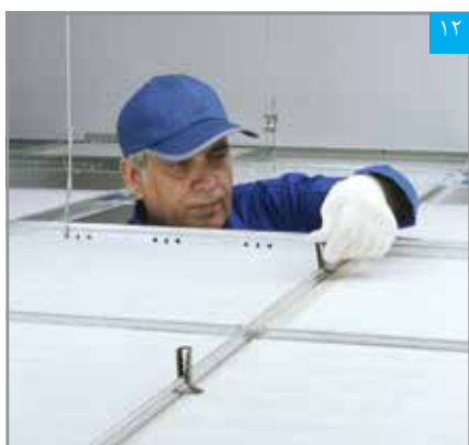
قرار دادن گیره‌های مخصوص نگهدارنده تایل
