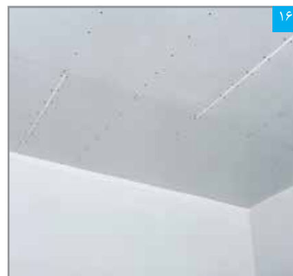
پنل گذاری تکمیل شده (به صورت حصیرچین)
