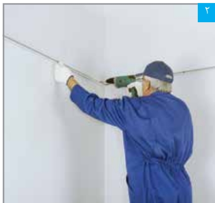
نصب سازه تراز پس از تعیین خط تراز سقف
