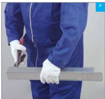
۶ برش سازه پشت بند درز (به صورت زیانه)
