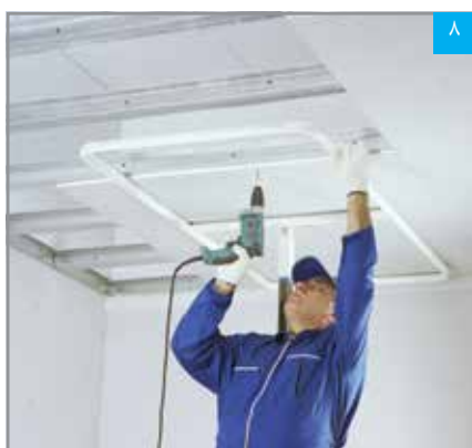
اتصال پنل به زیرسازی توسط پیچ
