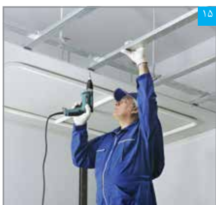
اتصال پنل به زیرسازی توسط پیچ
