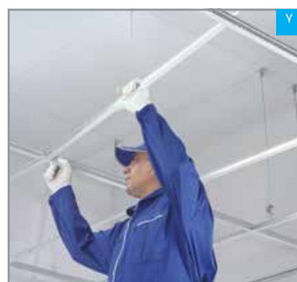
اجرای سازه‌های فرعی T1200
