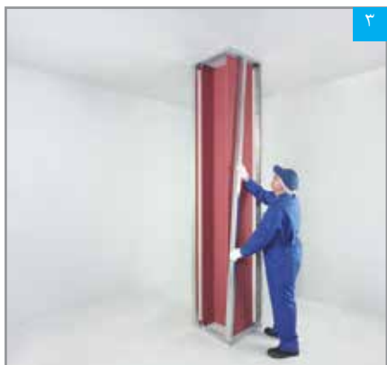
۳ استقرار استاده‌ها در رانتهای کف و سقف
