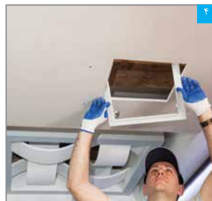
۴ قرارگیری قاب پیرامونی دریچه
