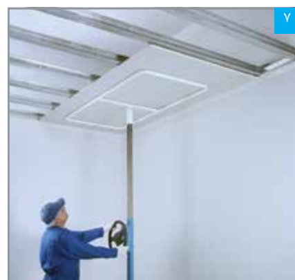
استقرار پنل با استفاده از بالابر
