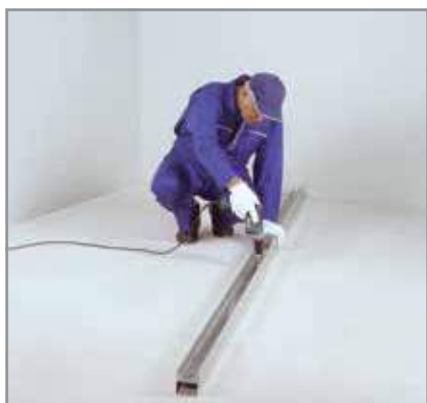
اجرای سازه سقفی دوتایی
