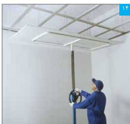
استقرار پنل با استفاده از بالابر
