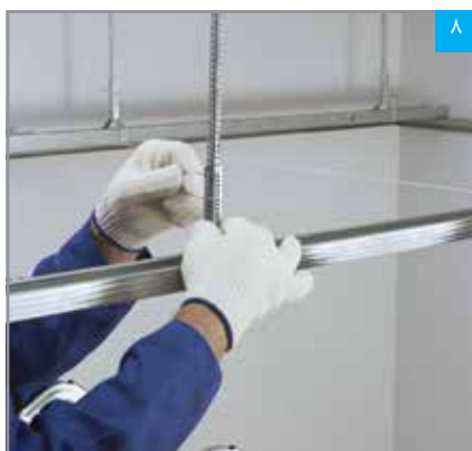
۸ اتصال رکاب به آویز و رگلاژ سقف توسط پین
