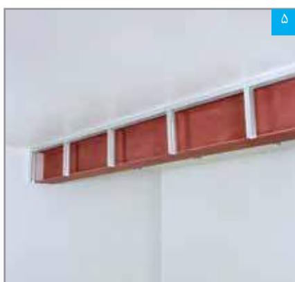
سازه‌های فوقانی و قائم تکمیل شده
