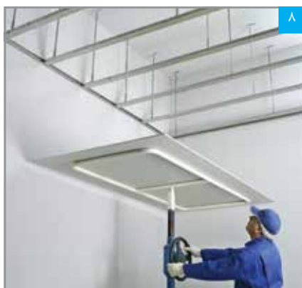
استقرار پنل با استفاده از بالابر
