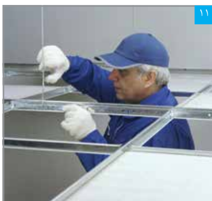
تنظیم ارتفاع سقف
