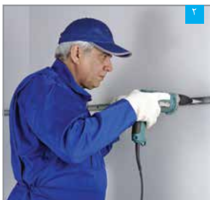
نصب سازه تراز
