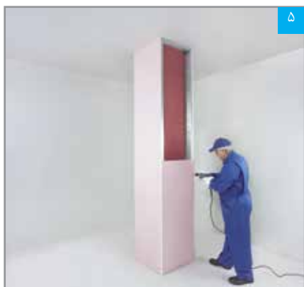
۵ اجرای پنل‌های لایه اول
