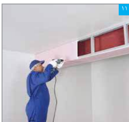
اجرای پنل جانبی
