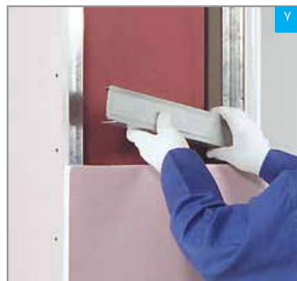
۷ استقرار سازه پشت بند درز (ما بین لایه پوششی و زیرسازی)
