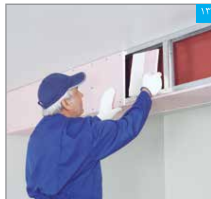
استقرار پنل پشت بند درز
