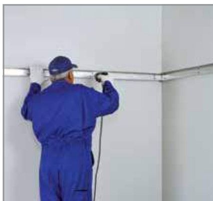
نصب سازه تراز باربر
